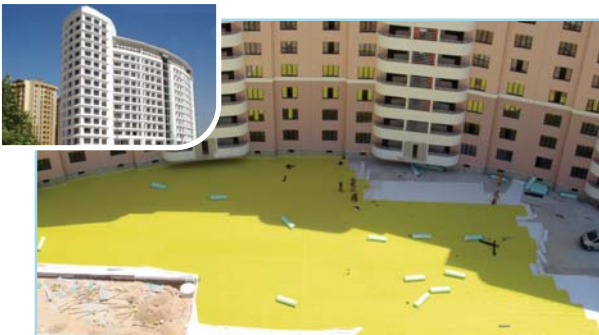
A Kent 2.800 m 2 Otopark Üstü PVC Membran Kaplaması (Konya)
