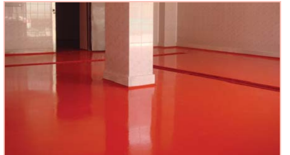
Yilet İşleme Tesisi 450 m 2 Epoksi Zemin Kaplaması
