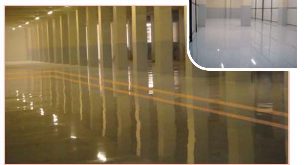
Halk (Biskot) Bisküvi 6.000 m 2 Epoksi Zemin Kaplaması (Karaman)
