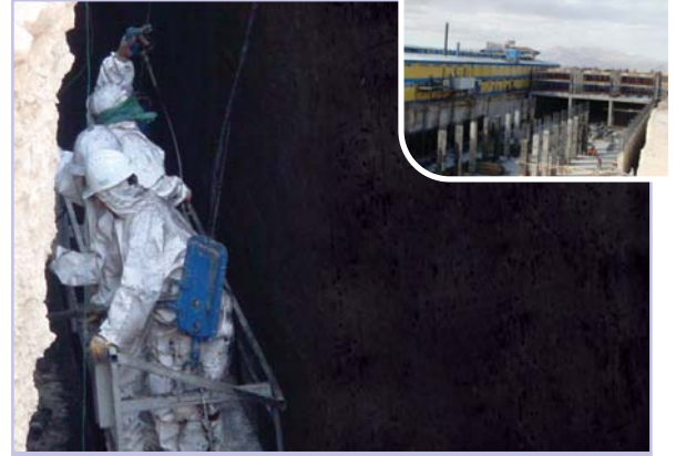
Biskot Bisküvi Fab. 2.800 m 2 Püskürtme Perde Su Yalıtımı (Karaman)
