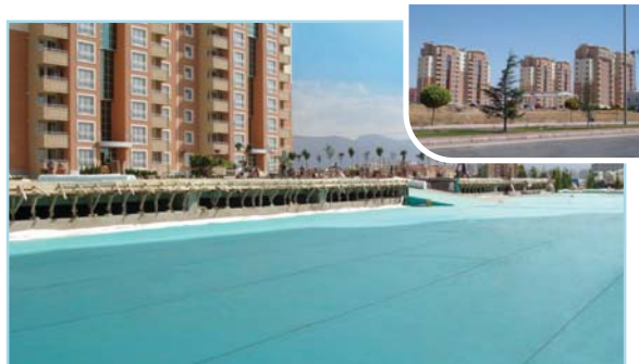
Asude Evleri 3.000 m 2 Sosyal Tesisi Zemin Üstü PVC Membran Kaplaması (Konya)
