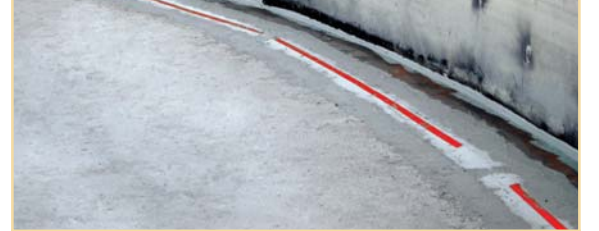
Konya Şeker Fabrikası Arıtma Tesisi 300 m.tül (Konya)
