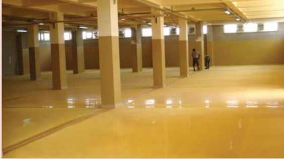
Bifa Bisküvi 1.800 m 2 Zemin ve 1.300 m 2 Duvar Epoksi Kaplaması (Karaman)
