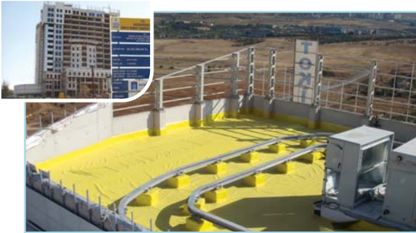
Tarım Bakanlığı 5.500 m 2 Teras ve Sosyal Tesis Üstü PVC Membran Kaplaması (Ankara)
