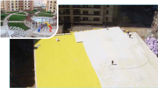
Gardenya 7.000 m 2 Otopark Üstü, Bahçe, Çatı ve Teras PVC Membran Kaplaması (Konya)
