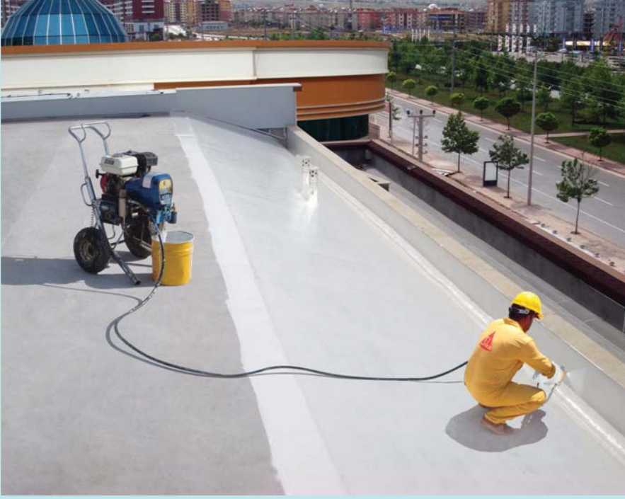
Kızılkaya İş Mrk. 600 m 2 Teras Çatı Püskürtme PU Su Yalıtımı (Konya)
