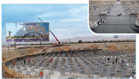
Bilim Merkezi 11.500 m 2 Fore Kazık ve Tem. Boğç. EPDM Memb. Kap. (Konya)
