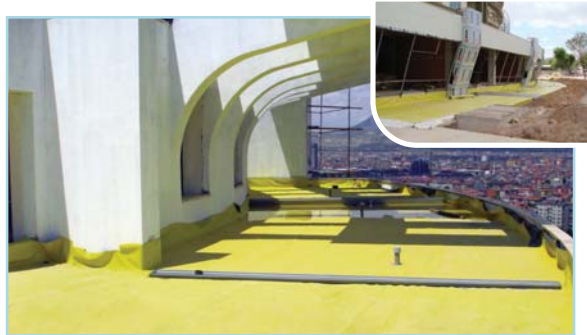
Kule Konakları 5.000 m 2 Teras ve Otopark Üstü PVC Membran Kaplaması (Konya)
