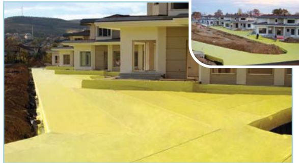
Meram Villaları 2.000 m 2 Otopark Üstü PVC Membran Kaplaması (Konya)
