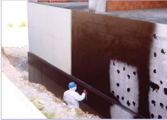
Adalet Plaza (Kom Yapı) 2.000 m 2 Püskürtme Perde Su Yalıtımı (Konya)
