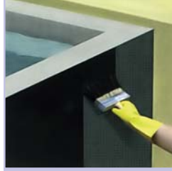
Fırça ile Su Yalımı Uygulaması
