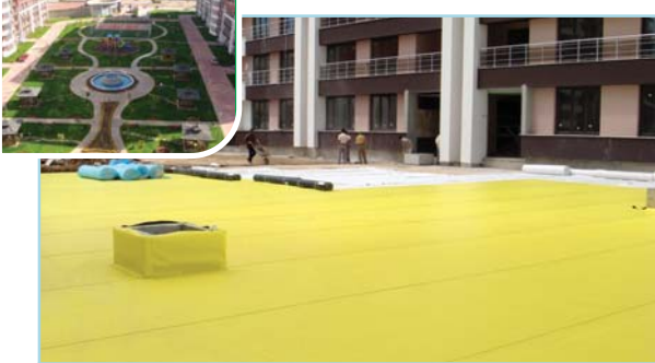
Lale Park 6.500 m 2 Otopark Üstü PVC Membran Kaplaması (Konya)
