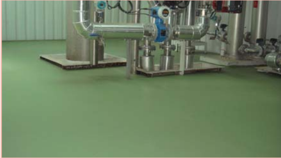
Çumra Şeker Fab. 1.900 m 2 Poliüretan Zemin Kaplaması (Konya)
